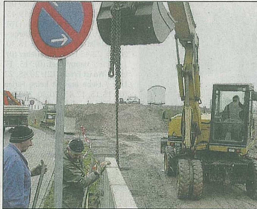
Vor wenigen Tagen begannen im Gewerbegebiet die Bauarbeiten für ein modernes Logistikzentrum der Firma Cosmocolor. Mitte nächsten Jahres soll es eingeweiht werden. FOTO: frankphoto.de
